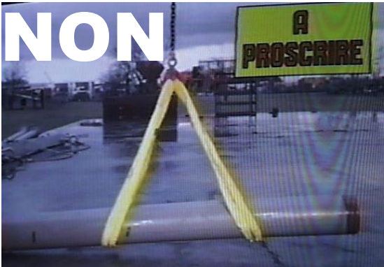
2 estropes travaillant en panier
